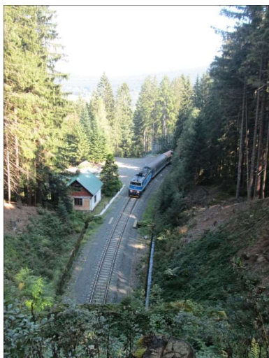
Rekonstrukce trati Klatovy - Železná Ruda – II. fáze
