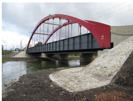
Rekonstrukce mostu v km 232,992 trati Chomutov-Cheb
