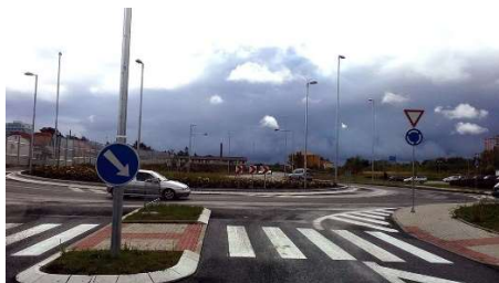
Silnice I/9, I/16 Mělník, obchvat, 1. stavba
