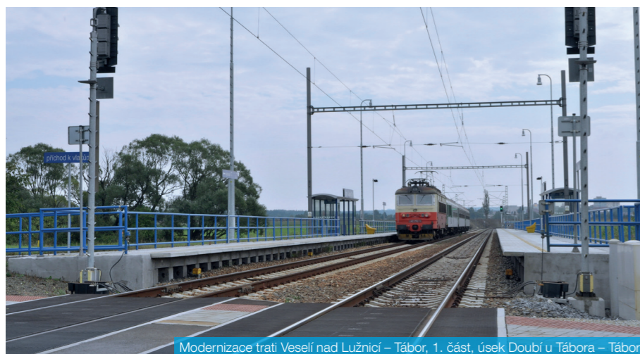
Modernizace trati Veselí nad Lužnicí – Tábor, 1. část, úsek Doubí u Tábora – Tábor
