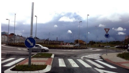
Silnice I/9, I/16 Mělník, obchvat, 1. stavba
