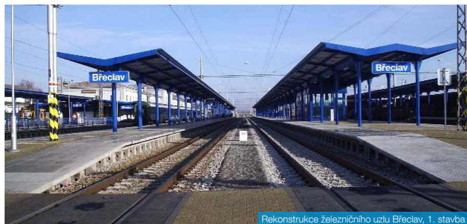
Rekonstrukce železničního uzlu Břeclav, 1. stavba
